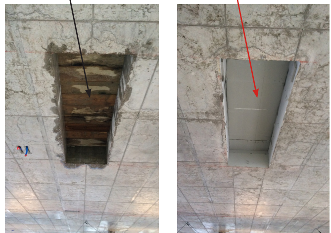
Aussparungen im Vergleich: Wassereintritt bei der konventionellen Aussparung trotz aufwendiger Abdichtung
