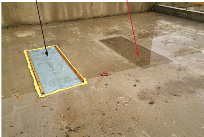
Aussparungen im Vergleich: Wassereintritt bei der konventionellen Aussparung trotz aufwendiger Abdichtung
